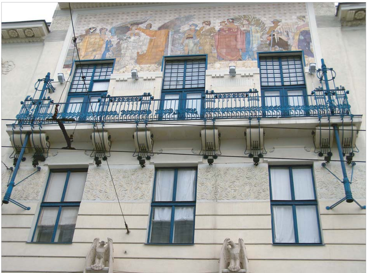
Фасад ощадної каси. 1901 р. Чернівці
