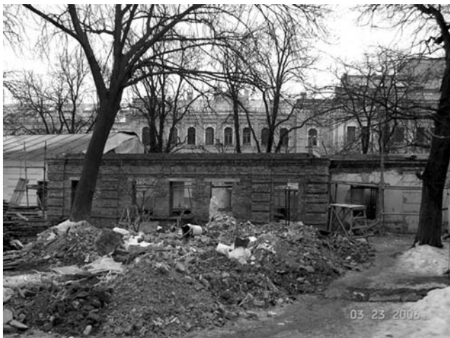
Руйнування будівель в районі Галицького. Фото зроблено в 2006 році.
