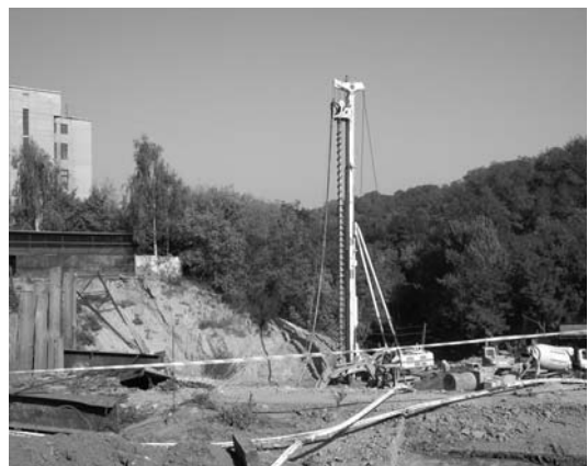
Будівництво на пагорбі. На задньому плані видно лісовий масив.
